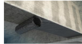
Наклеивание углеволокна
